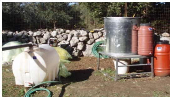
Impostazione di un sistema di pre-trattamento su scala pilota a Creta, Grecia
